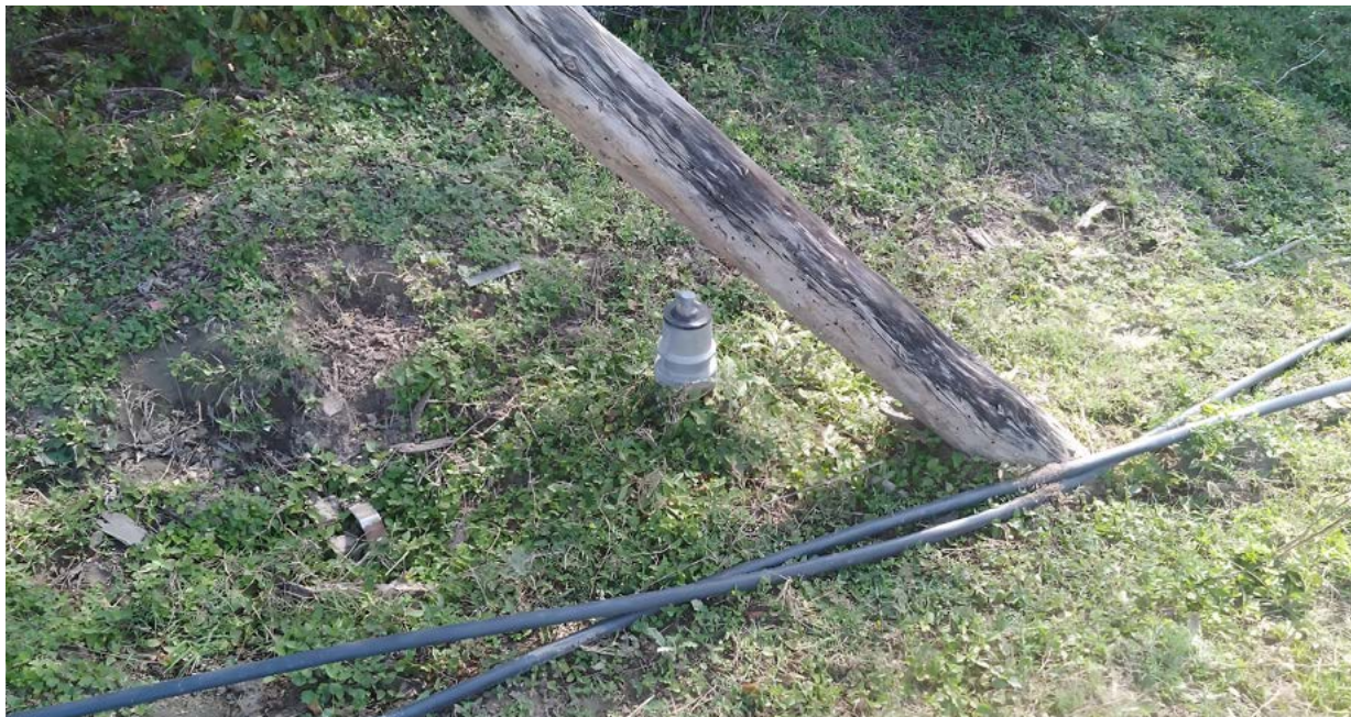
Fotografía 2. Válvula de seccionamiento colocada en la tubería
