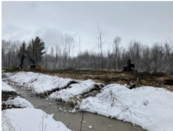
Photo 8. Zone de déboisement dont le bois est fraîchement coupé et où deux broyeurs forestiers sur pelle hydraulique travaillent actuellement à faire le déchiqueta du bois (GPS 017, vue vers le nord)
