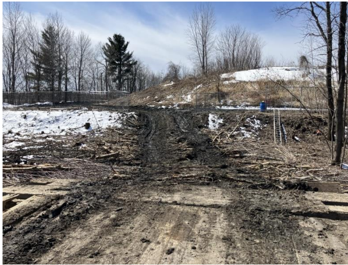
Photo 17. Les approches du pont # 1 sont composées de poutres de bois recouvert résidus de végétaux (GPS 045, vue vers le sud-ouest)
