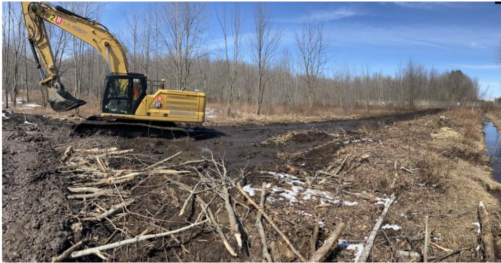
Photo 26. Réparation des ornières (GPS 038, vue vers le nord-ouest)
