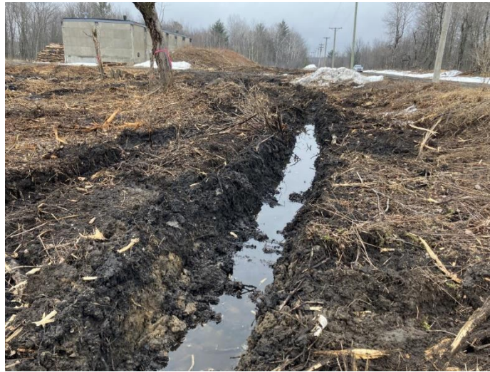
Photo 2. Ornières dans le sol causé par la circulation de la machinerie (GPS 081, vue vers le sud-est)
