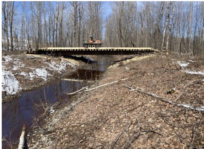
Photo 14. Le pont # 1 se situe au point GPS 045. Le pont repose sur des assises de bois en forme de H situées dans la rive (GPS 045, vue vers le nord-ouest)
