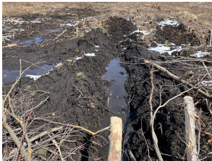
Photo 24. Ornières dans le sol causé par la circulation de la machinerie (GPS 038, vue vers le nord-est)
