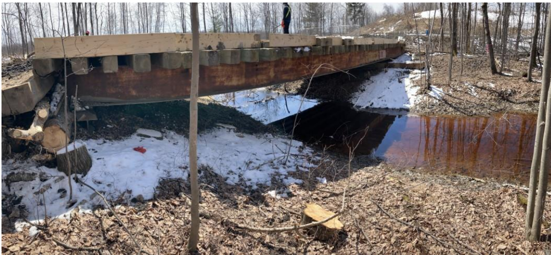
Photo 15. Le pont # 1 se situe au point GPS 045. Le pont repose sur des assises de bois en forme de H situées dans la rive (GPS 045, vue vers le sud)
