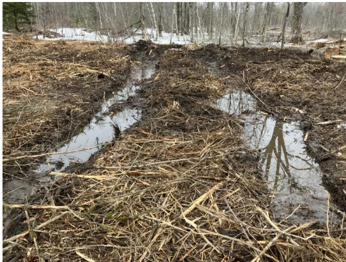
Photo 22. Ornières dans le sol causées par la circulation de la machinerie (GPS 106, vue vers le sud-est)
