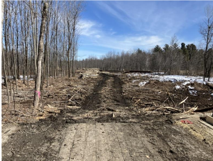
Photo 16. Les approches du pont # 1 sont composées de poutres de bois recouvert résidus de végétaux (GPS 045, vue vers le nord-est)
