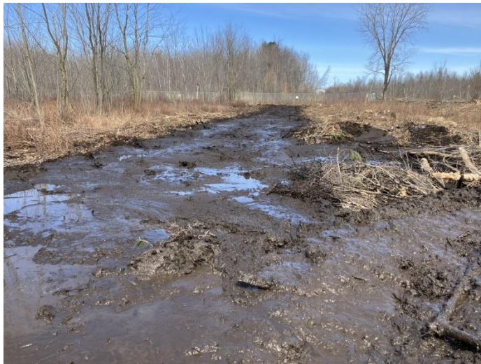
Photo 27. Réparation des ornières (GPS 038, vue vers le nord)
