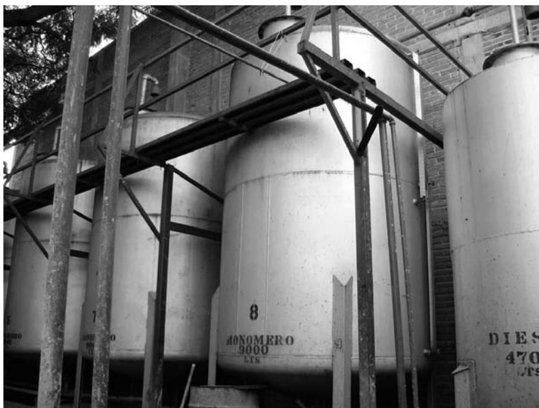
**Foto Núm. 4.** Granja de tanques de almacenamiento de productos químicos. Se aprecia la ausencia de señalización en comunicación de riesgos. En la parte posterior se observa la barda que colinda con el domicilio del Peticionario.
