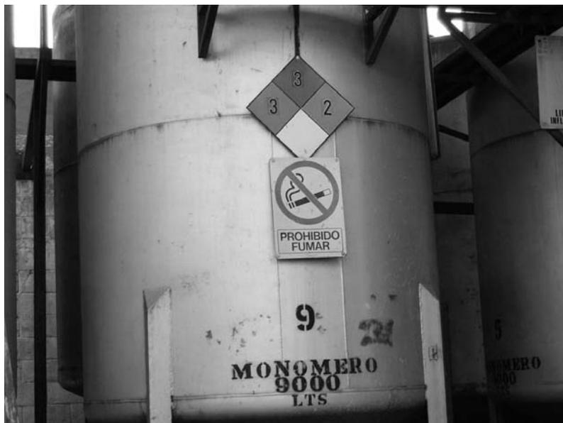
**Foto Núm. 3.** Tanque de almacenamiento de monómero de estireno con capacidad de 9,000 litros. Sólo algunos de los tanques se observaron con los señalamientos correspondientes.
