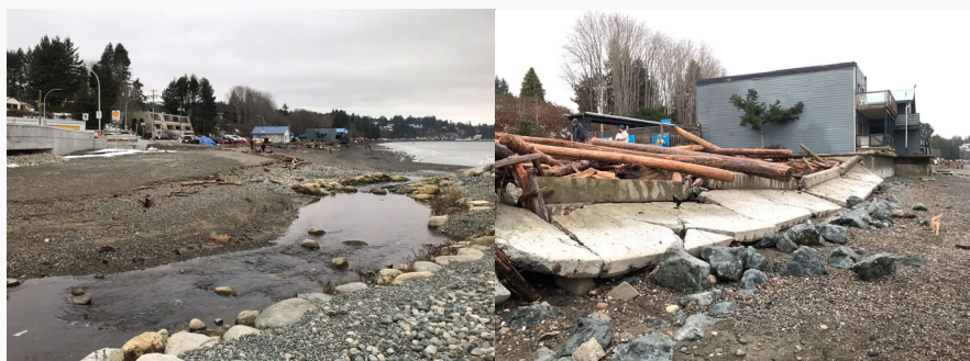
Gráfica 18. Fotografías de la línea costera tras la tormenta del 7 de enero de 2022, (izquierda) a lo largo del estuario restaurado del arroyo, y (derecha) a lo largo de un tramo adyacente de la costa, en el que falló el malecón
