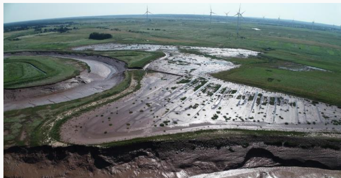
Gráfica 2. Vista aérea oblicua del sitio de reposicionamiento controlado del dique de Converse, en el istmo de Chignecto
