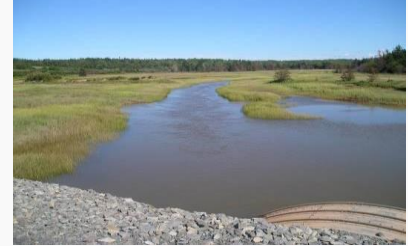
Gráfica 8. Instalación de nuevo paso de agua en 2005
