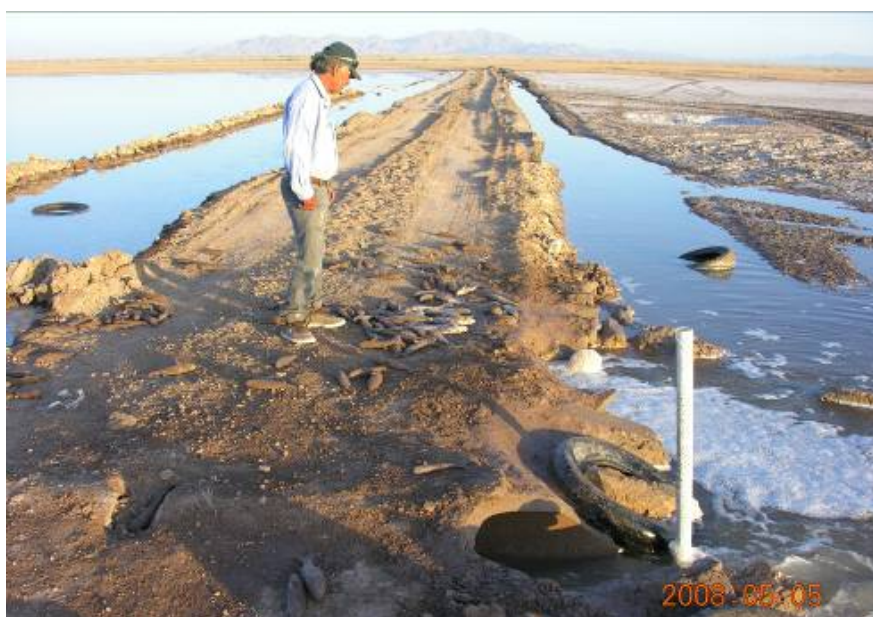
Figura 5. Camino que cruza y obstruye el río Colorado a la altura del poblado del Indiviso. El camino fue construido para pasar del poblado hacia la carretera hacia San Felipe – un ahorro de al menos una hora de camino. EL camino tiene 2 alcantarillas las cuales se colapsaron y limitan el paso de regreso al mar de peces que lograron subir río arriba con las mareas. En la foto se observan decenas de lisas muertas en el camino al intentar cruzar. En la foto se observa un tubo de PVC en donde se colocó un sensor de nivel de agua.
