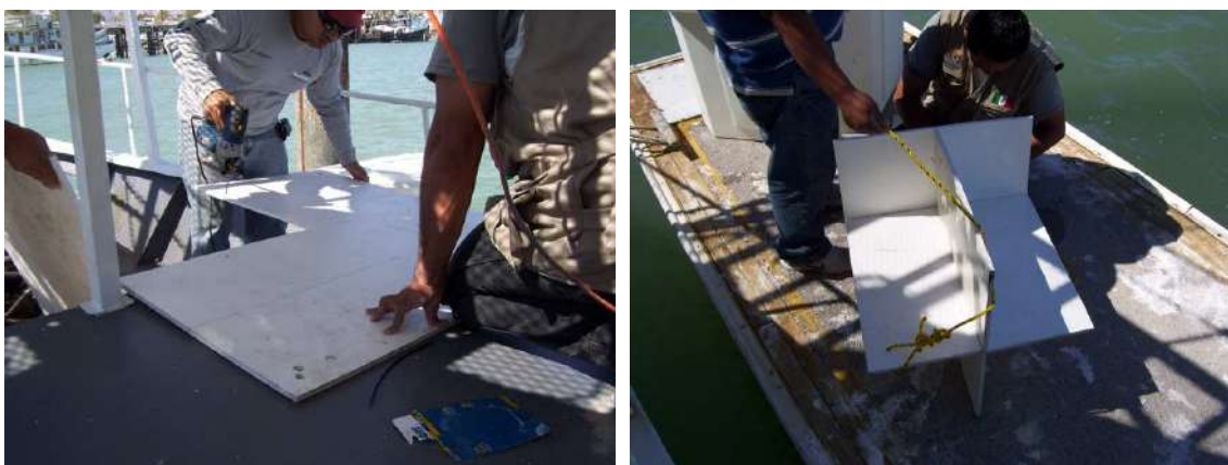
Figura 42. Prototipo de reflector de sonar usado durante la prueba piloto. Se construyó a partir de una placa de policarbonato de 4x4 pies. El diseño consta de tres planos ortogonales, lo que maximiza las posibilidades de reflexión y, por tanto, ocasiona una señal intensa en el sonar.
