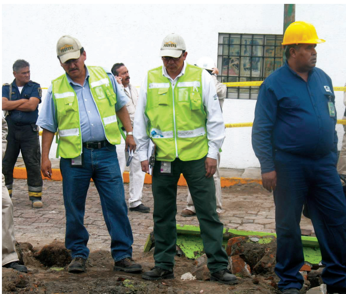
Inspección a ductos de PEMEX.
