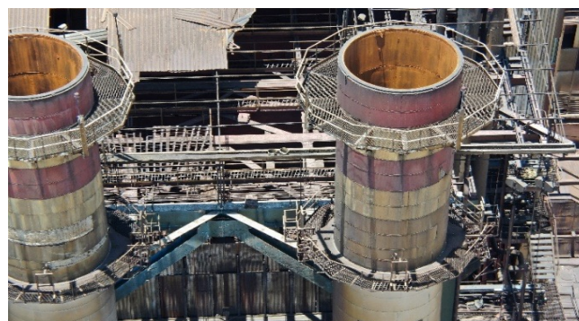
Emisiones de una planta Termo Eléctrica
