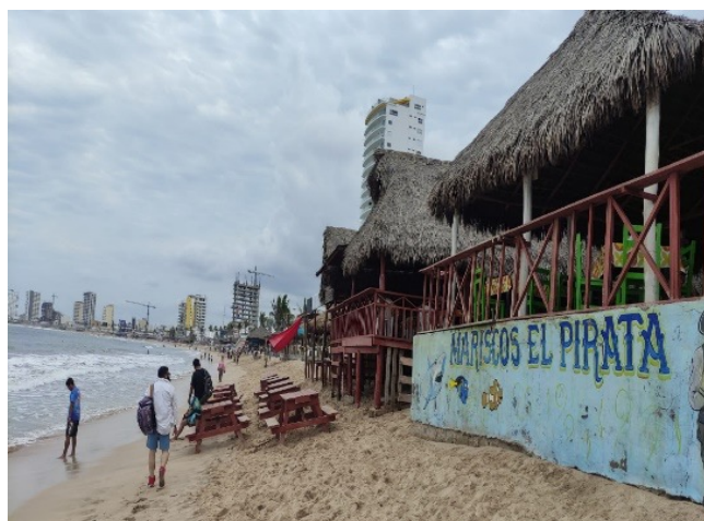
Inspección en la Zofemat, Sinaloa
