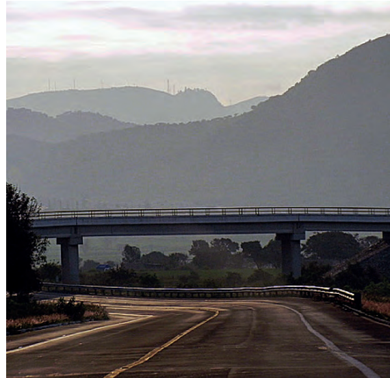
Construcción de puentes y distribuidores viales
