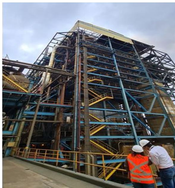
Instalación de jurisdicción federal
