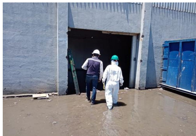
Atención de derrame de sustancias tóxicas
