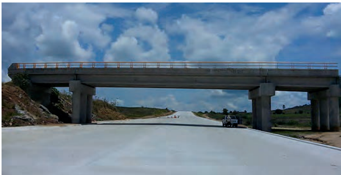
Obras de modernización en carretera
