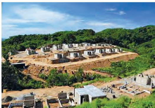
Construcción de viviendas en Agua de Perro, Acazulco de Juárez
