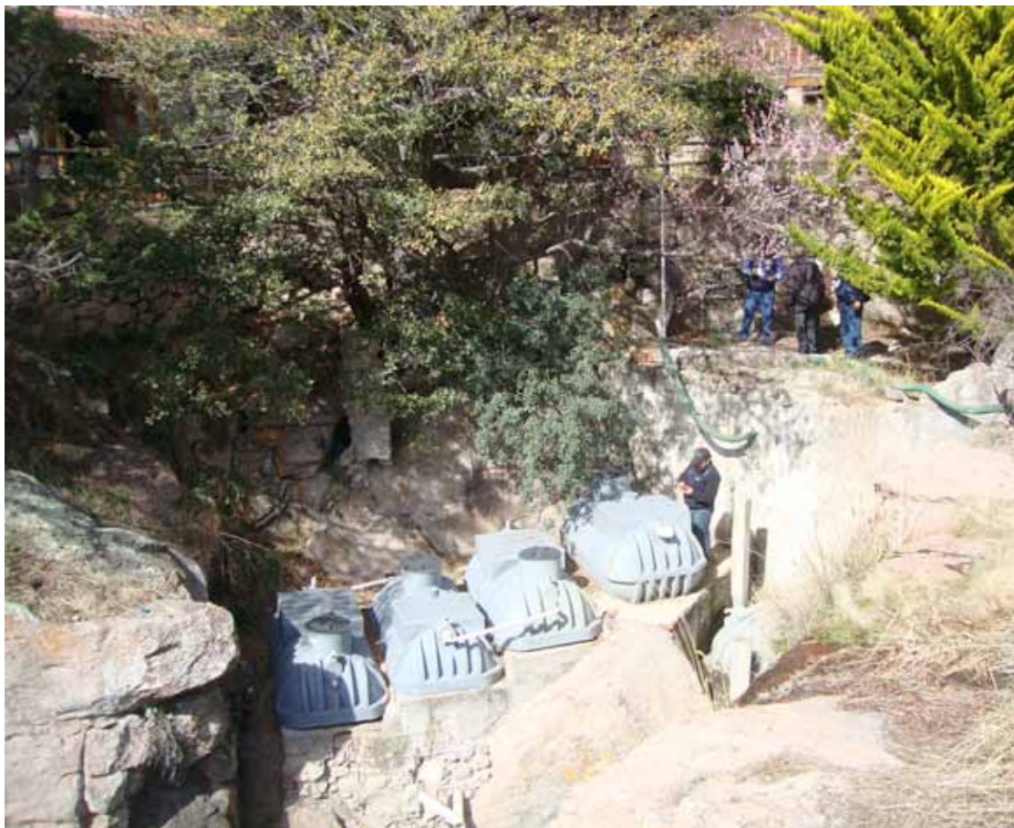
Inspección a planta de tratamiento
