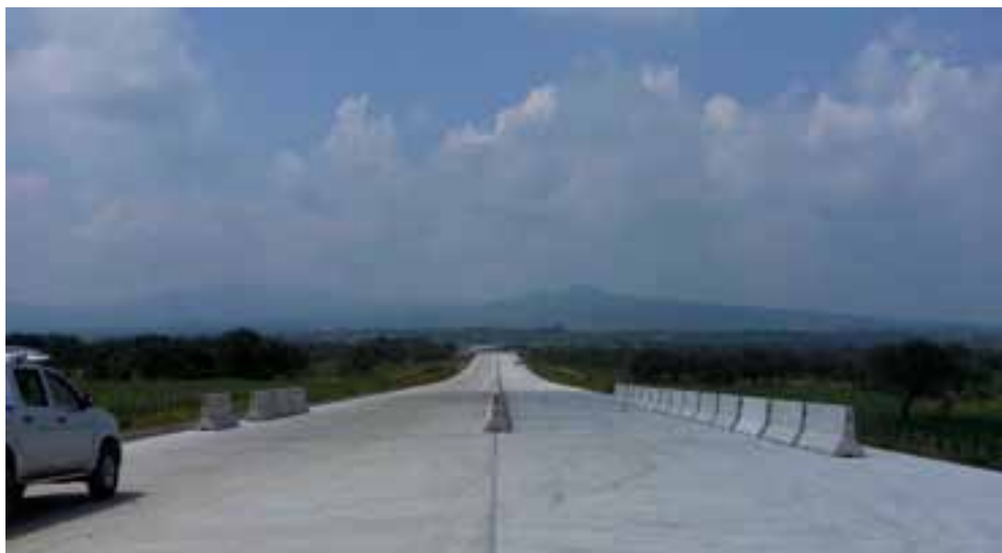
Tramo concluido del proyecto carretero
