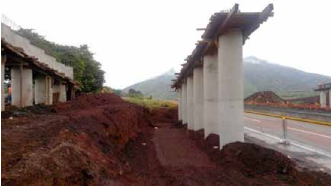
Construcción de infraestructura carretera en Jalisco
