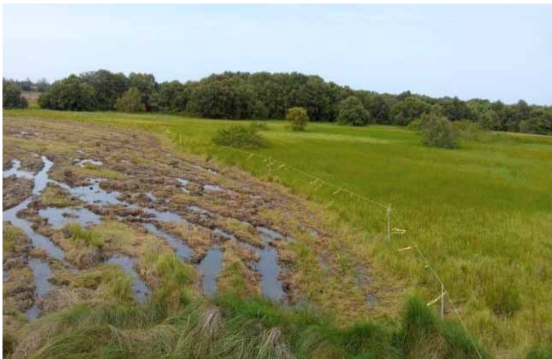
Verificación de franja de amortiguamiento con ecosistema de manglar
