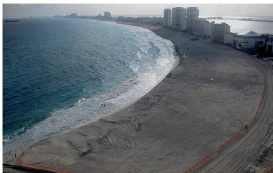
Trabajos de vertimiento de arena en la zona federal marítimo en las playa de la zona hotelera de Cancún, Quintana Roo
