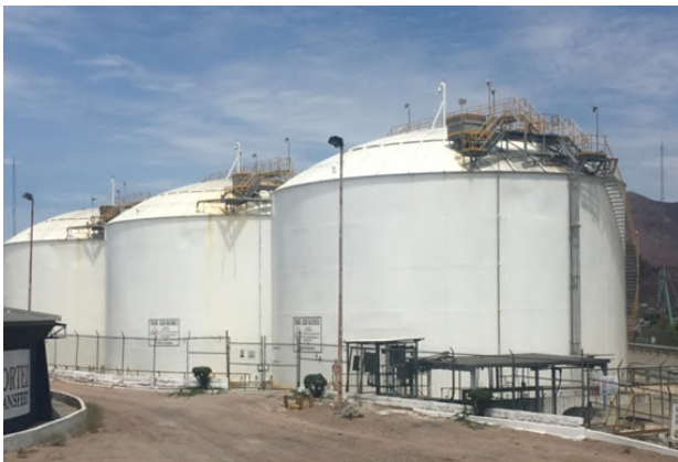
Instalaciones para almacenamiento de ácido sulfúrico clausuradas en la Terminal Marítima en Guaymas, Sonora
