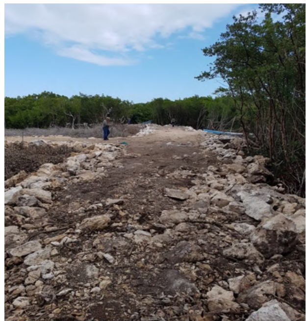
Afectación de humedal de manglar por invasión de asentamientos irregulares, Ría Lagartos, Yucatán
