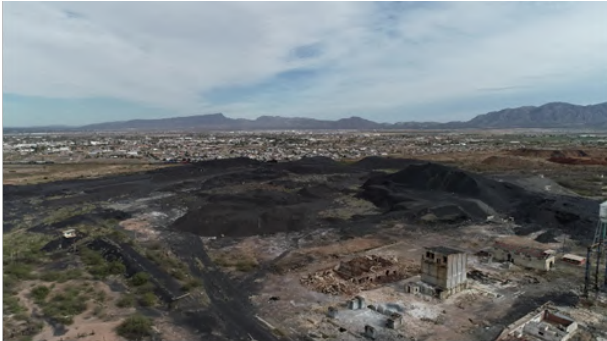
Verificación en sitio contaminado con residuos peligrosos
