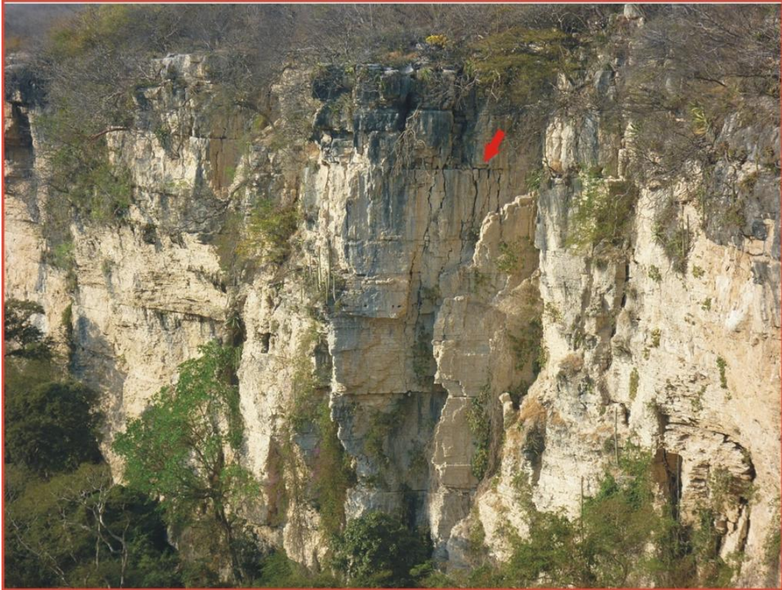
Figura 3: Fisuras en la pared del Cañon Sumidero a lado de la Empresa Cales y Morteros de Grijalva SA de CV. Fuente: Foto propio.
