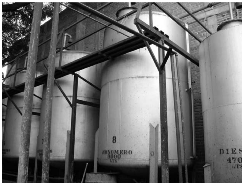
Photo n° 4 : Bâtiment abritant des réservoirs d'entreposage de produits chimiques. On note l'absence de signalement des risques. On voit à l'arrière le haut du mur qui jouxte le domicile de l'auteur.
