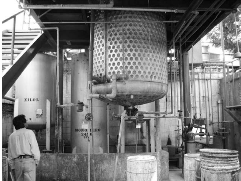
Photo n° 5 : Réacteur dans lequel on produisait le latex. Les fûts étaient utilisés pour acheminer le produit à l'aire d'imprégnation. Au fond, on voit les réservoirs de jour pour le xylol et le monomère de styrène.
