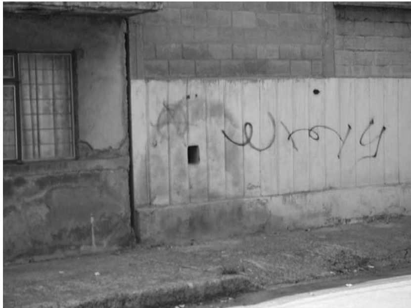
Photo n° 2 : Aire de livraison des solvants (xylol et styrène) adjacente au domicile de l'auteur au n° 11, Cerrada de Vaqueros . On observe un orifice dans le mur où l'on introduisait un tuyau pour la livraison du produit.
