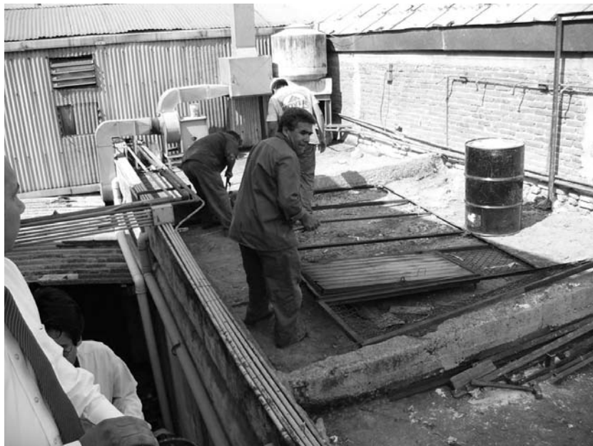
Photo n° 10 : Démantèlement de l'usine d'ALCA
