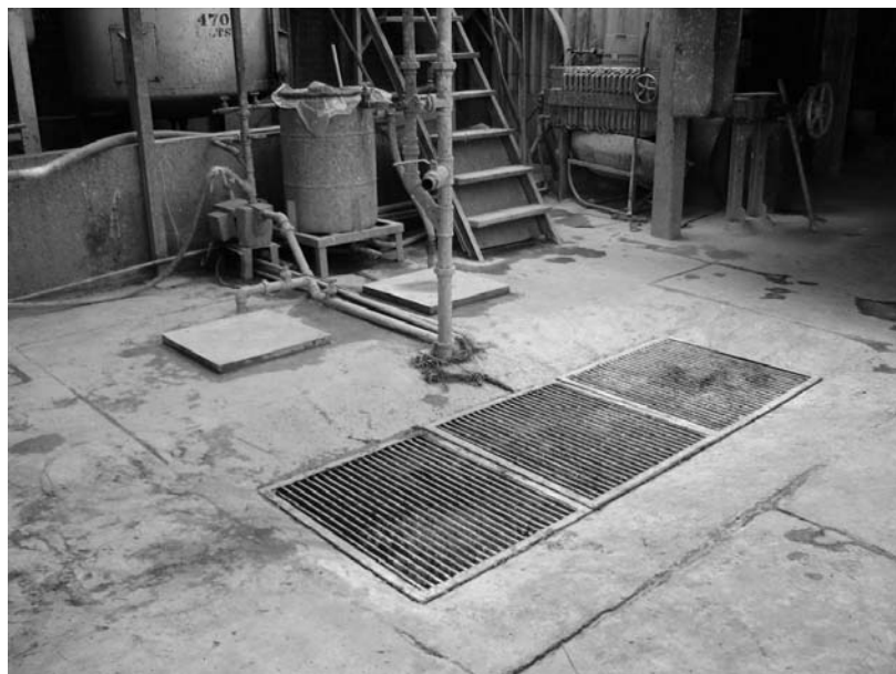
Photo n° 6 : Vue de l'atrium où l'on réalisait la préparation de l'activant. Le processus était réalisé à l'air libre. On voit aussi une grille pour récupérer les déversements de produit.
