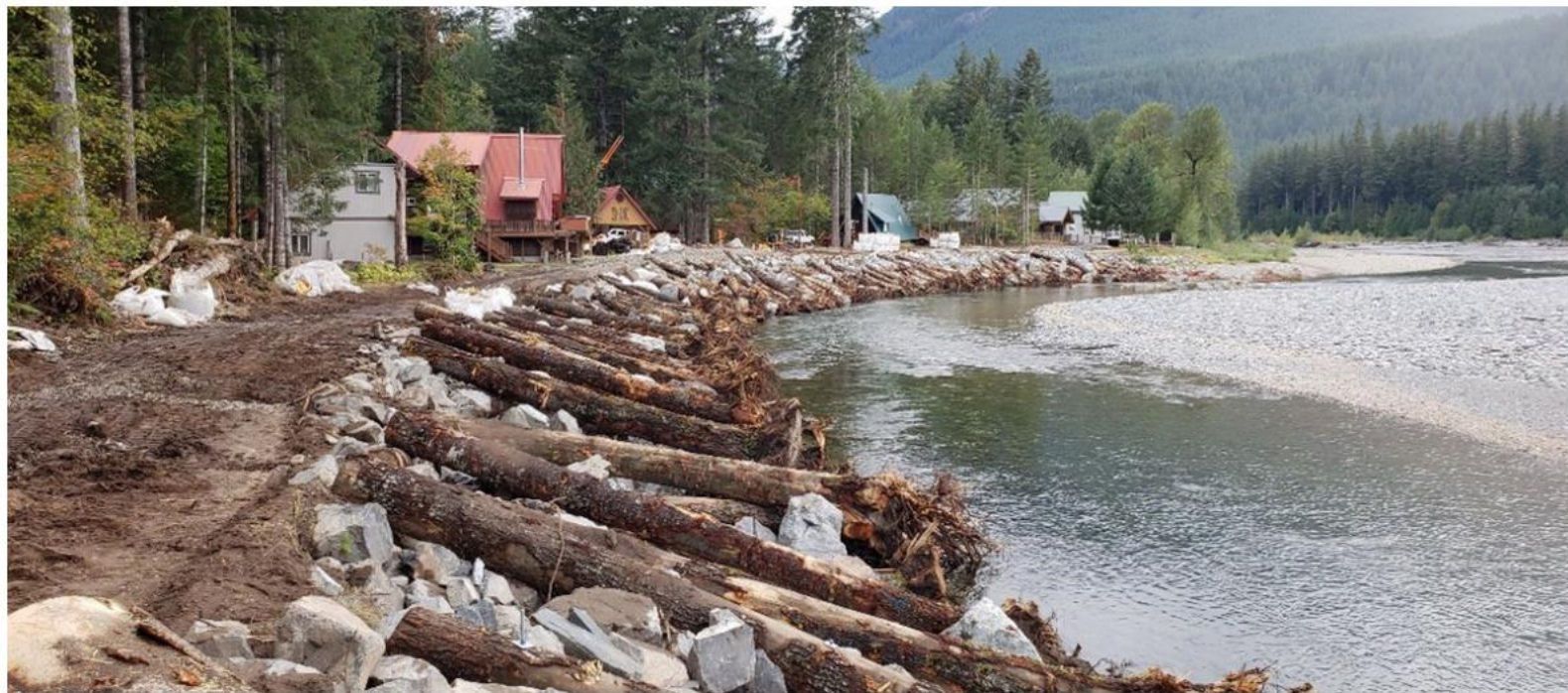
Proyecto de protección de orillas a largo plazo de Coal Creek Drive
