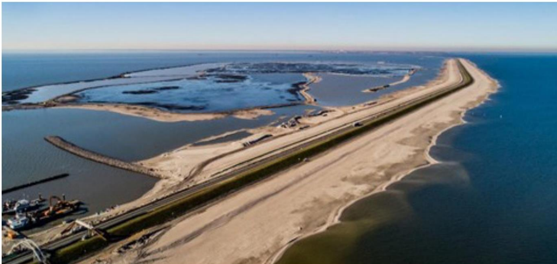
Refuerzo de arena de la presa de Houtribdijk
