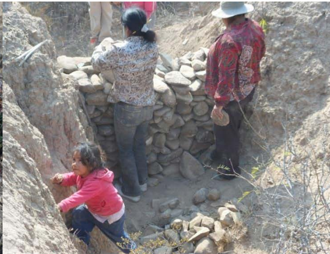
Construcción de Presas Filtrantes de Piedra Acomodada
