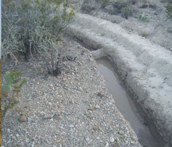
Zanja bordo para retención de Humedad y Maguey Forrajero
