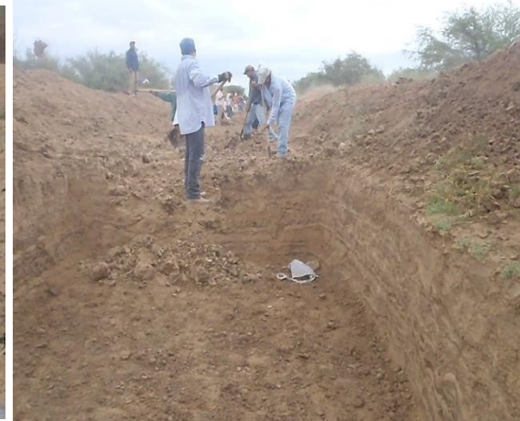
Excavación y nivelación del Canal
