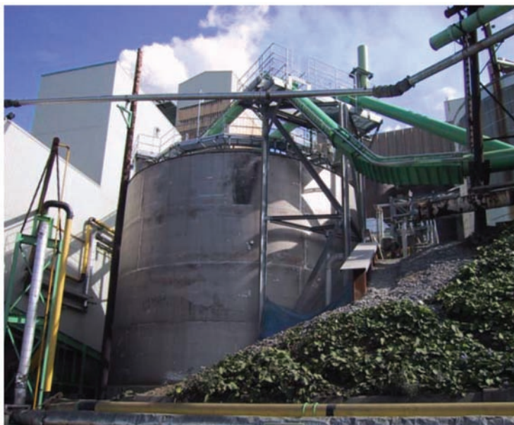
Gráfica 13. Irving Pulp and Paper – MBBR (fotografía cortesía de Irving)
