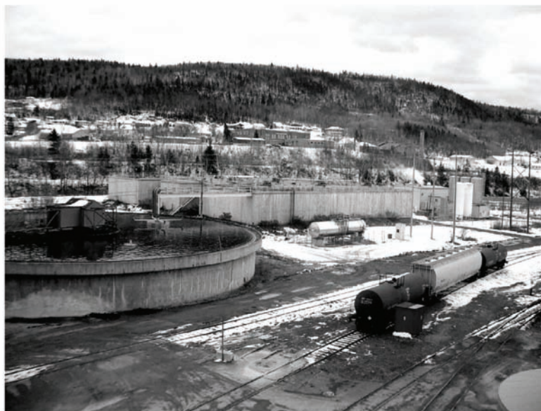
Gráfica 16. Clarificadores y reactor de oxígeno, AV Cell
