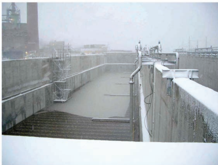
Gráfica 5. Tanques de oxigenación del sistema AST de ACI
