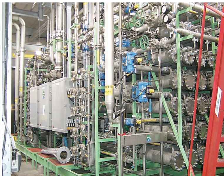
Gráfica 12. Irving Pulp and Paper – Planta de ósmosis inversa (fotografía cortesía de Irving)
