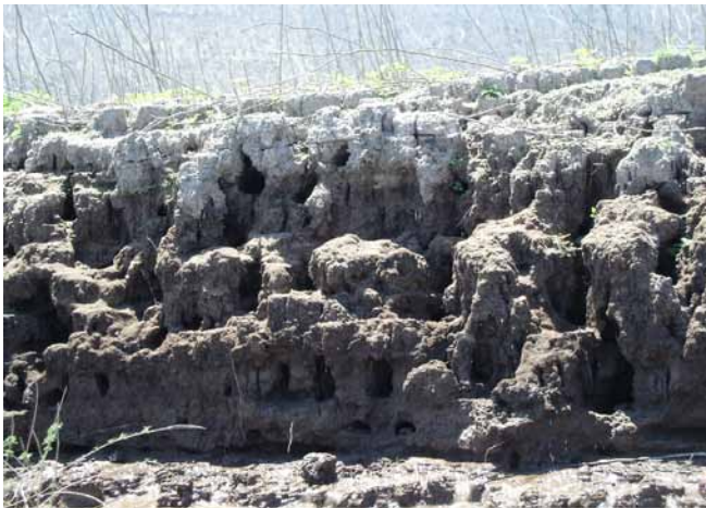
Gráfica 5.9. Galerías de anidación cavadas en la presa por loricáridos
