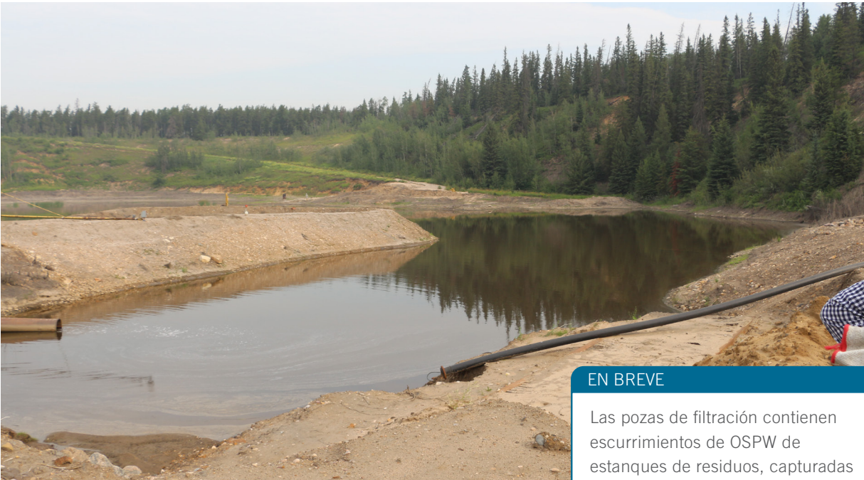
Foto 8. Poza de filtración de Syncrude en el lago Mildred y tubería de retorno al estanque de residuos
