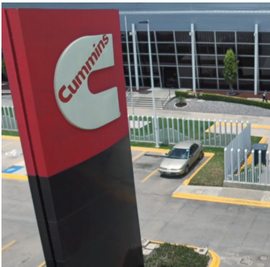
Planta Cummins Filtración SLP, San Luis Potosí, México.
