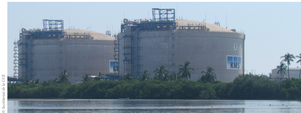
Photo 4 : Citernes de stockage de gaz naturel dans le bras II de la lagune de Cuyutlán
