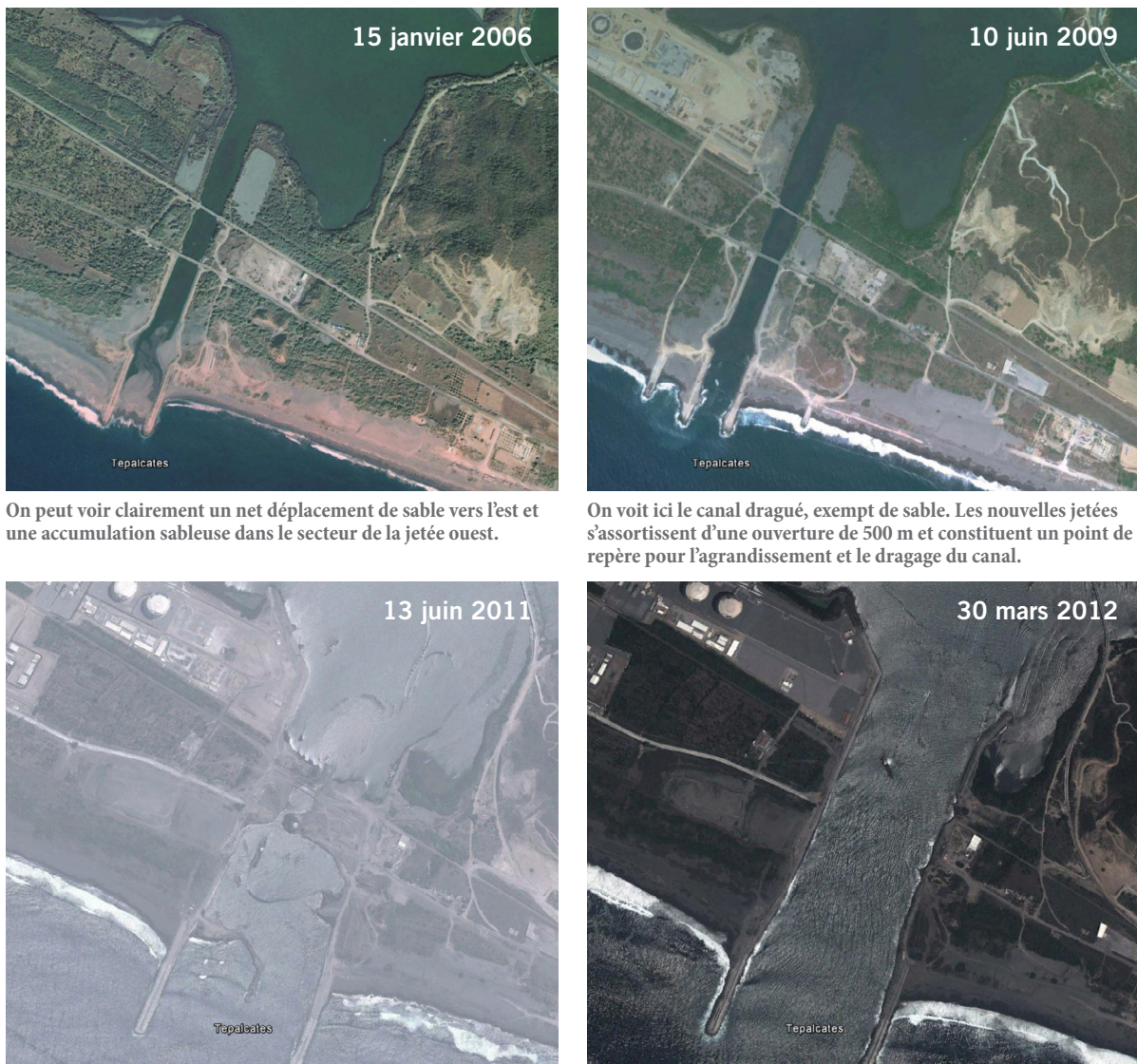
Figure A5-2 : Changements survenus dans le canal de Tepalcates entre 2006 et 2012
