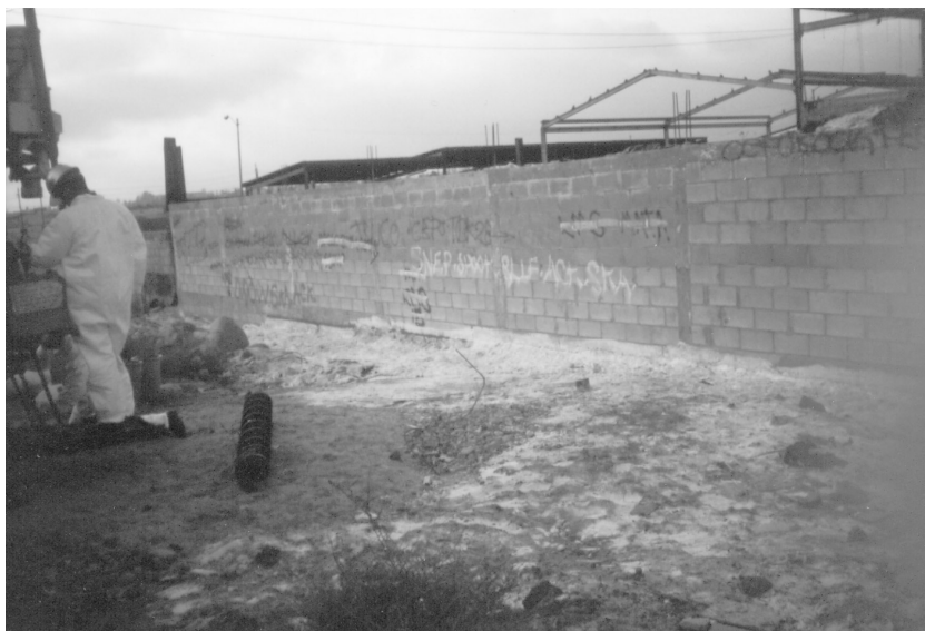
Foto núm. 1: Vista exterior de la pared del cajón de residuos al sur de la planta
