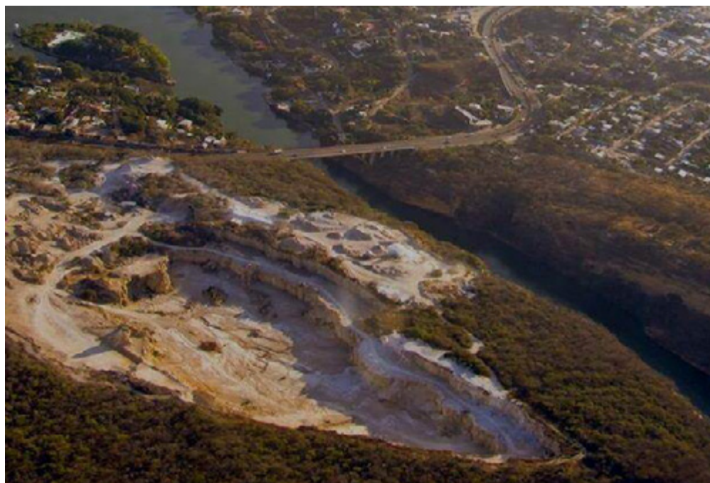
Photo 2. Site d'extraction de l'entreprise Cales y Morteros del Grijalva
