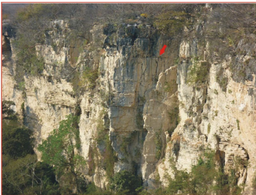
Figura 3: Fisuras en la pared del Cañon Sumidero a lado de la Empresa Cales y Morteros de Grijalva SA de CV. Fuente: Foto propio.
