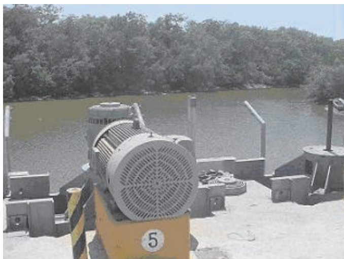
Installation d'amenée d'eau à La Cegada.
