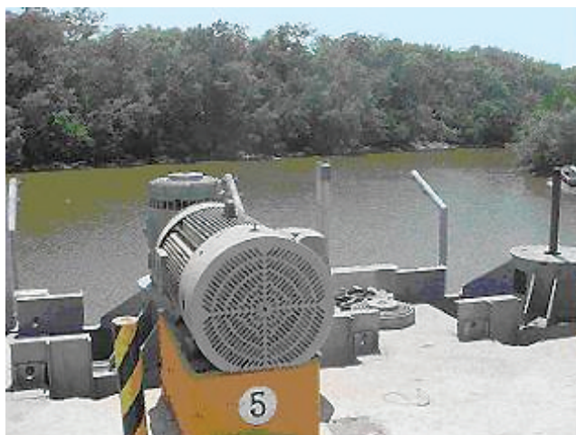
Estación de bombeo en La Cegada
