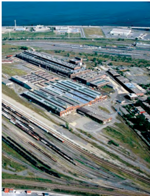
Figure 5 Vue aérienne (vers le Technoparc et le fleuve Saint-Laurent) des anciens ateliers du Canadien National dans Pointe-Saint-Charles 196
