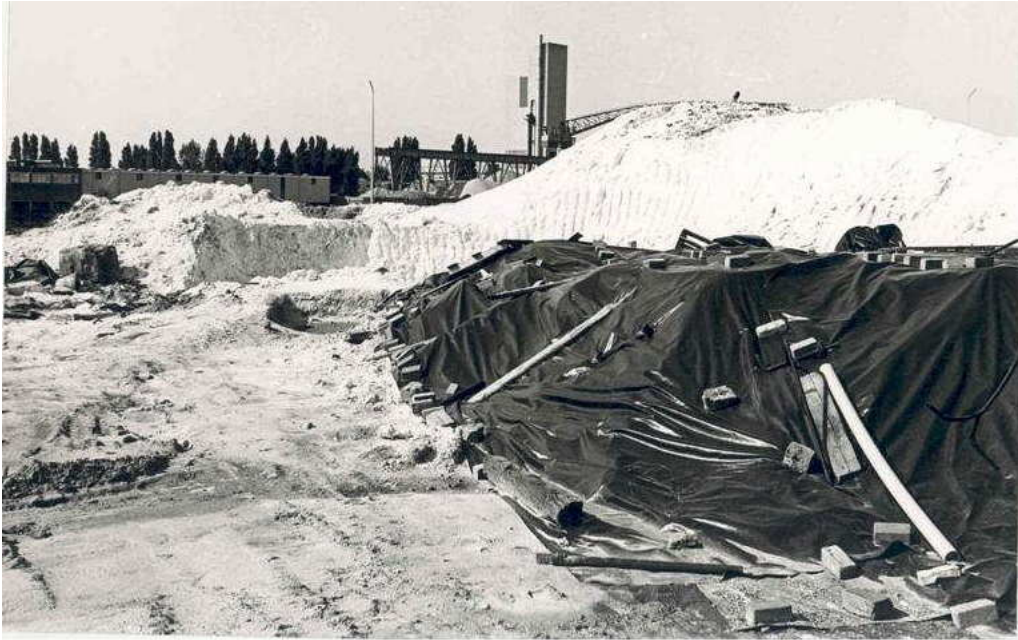
Photo 1. Cette photo a été prise pendant l'excavation des déchets d'isomères du HCH dans l'est des Pays-Bas. Ces déchets devaient être expédiés dans des mines de sel en Allemagne en vue de leur élimination.
