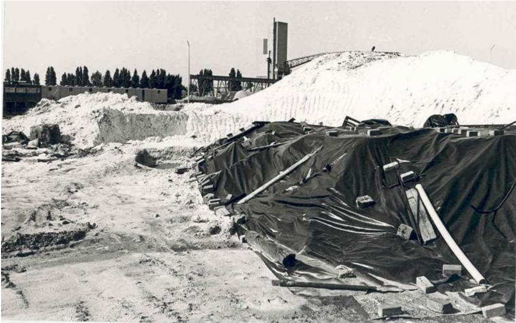
Foto 1. Esta foto se tomó durante la extracción de los isómeros residuales de HCH en la región este de los Países Bajos, que se enviarían a Alemania para su eliminación en salinas.
