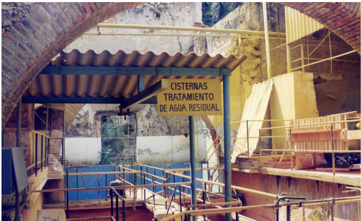
Foto 3. Planta de tratamiento de aguas residuales de la instalación 371
