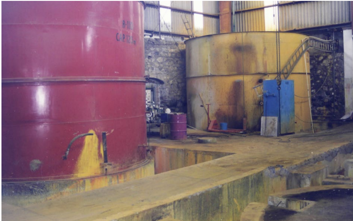
Foto 1. Tanques de precipitación 366
