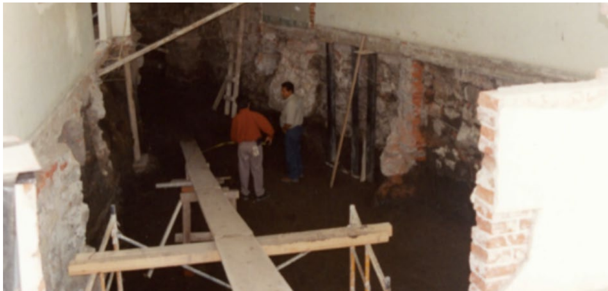
Foto 7. Excavación en el área de oficinas 718
