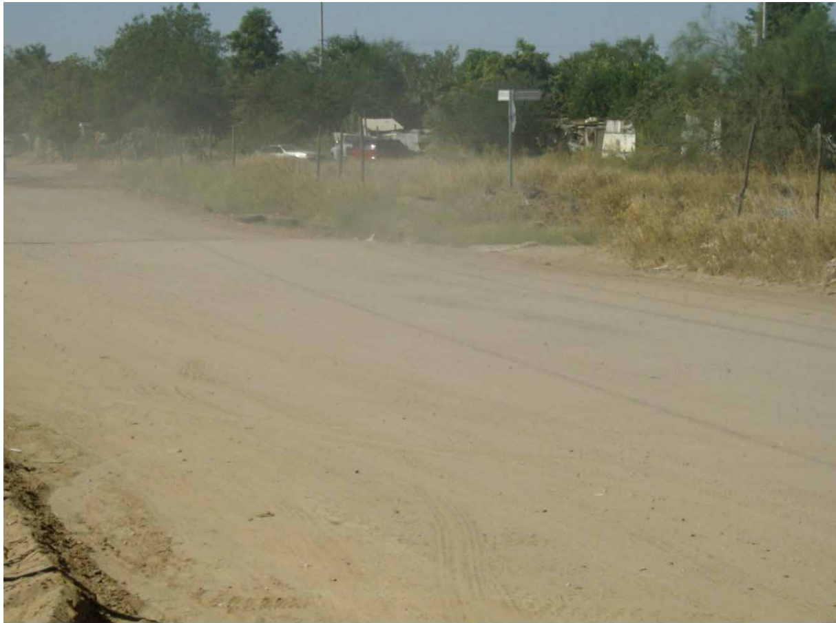
Calle sin pavimentar en Hermosillo. 369
